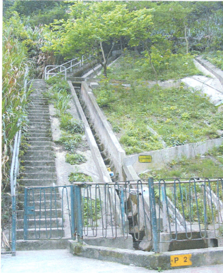
照片 7 人工斜坡上的現有植物及維修通道
