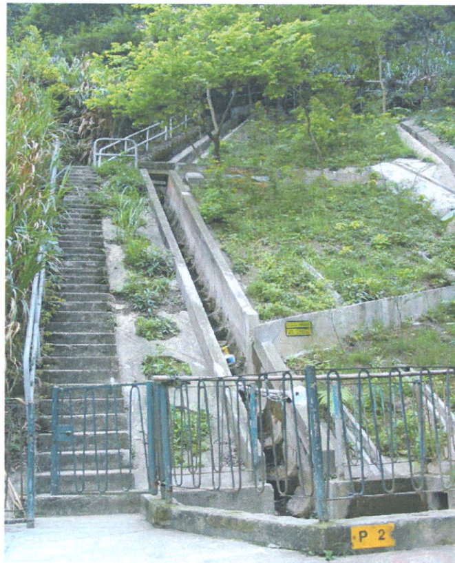
經工程加固斜坡
