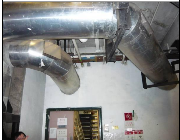
在醫院地下一層的焚化爐房外的水平煙道
