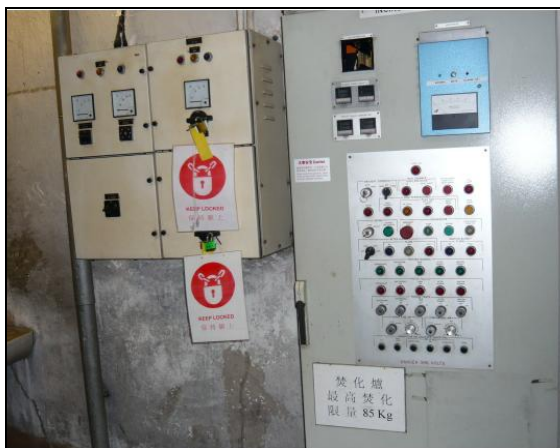
焚化爐的控制台及電源已被關閉
