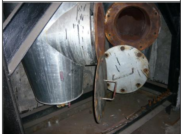
在煙道底部的灰收集器
