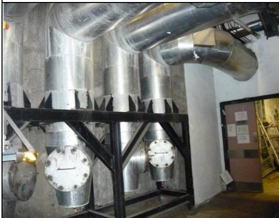
水平煙道與垂直煙道的連接點 (焚化爐的兩根煙道在右方；鍋爐的兩根煙道在左方)
