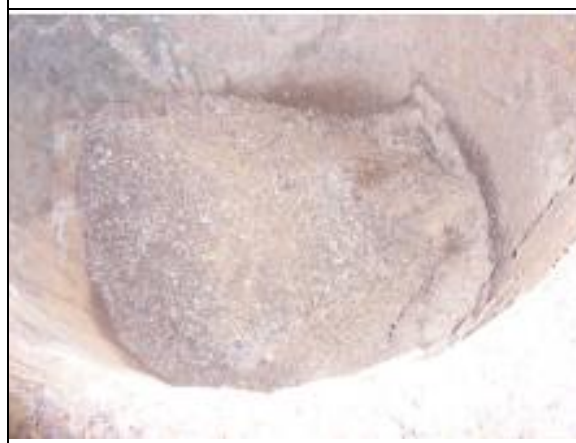
灰收集器(在煙囪底部)的殘餘爐灰
