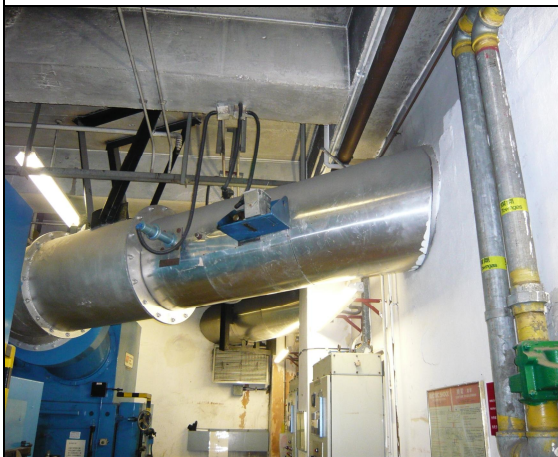
焚化爐房內的水平煙道
