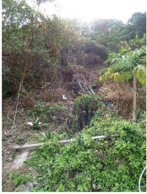
3, 現有的管道連接到通訊站
