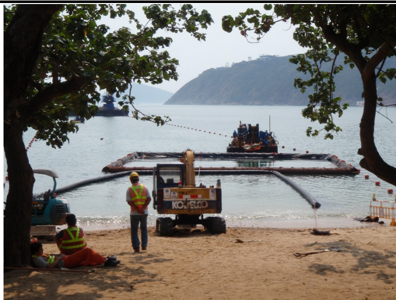
圖 4.1 為海灘的陸上工程和近岸的海上工程分別於海岸線和近岸的潛水員工作區安裝隔泥幕示例
