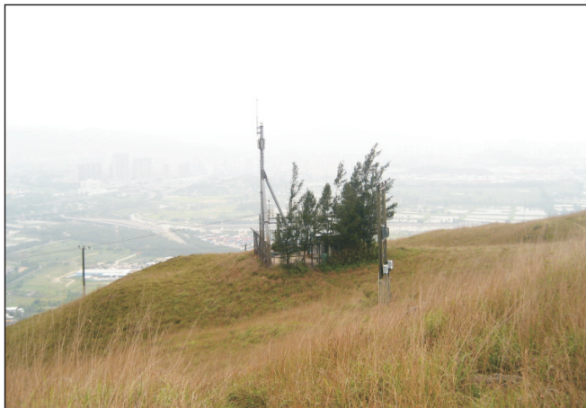
Overview of Project Site 工程項目地點概覽
