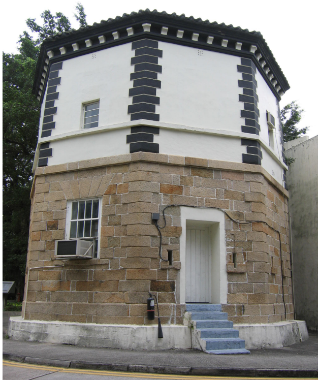
Old Prison Area, Block 319 (front view)第三百一十九座(舊監獄範圍)
