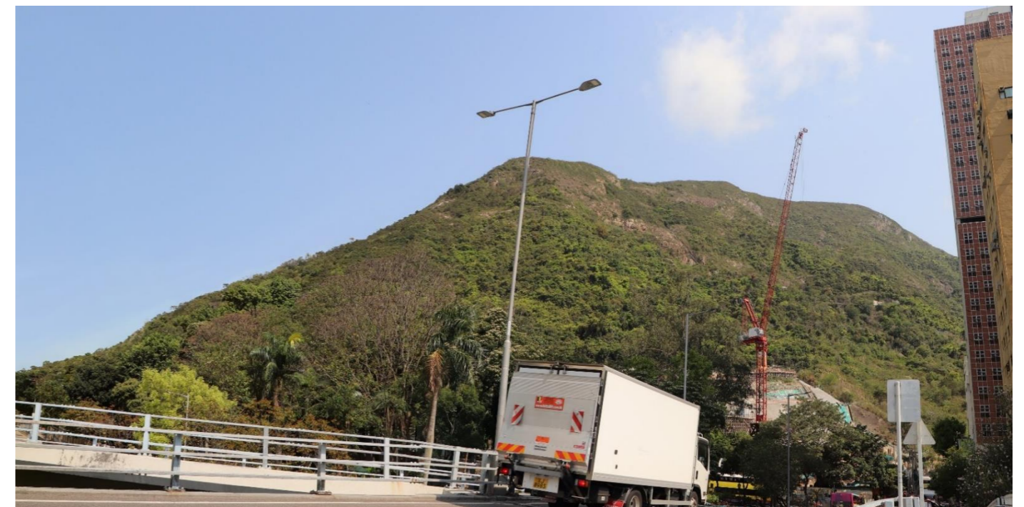
Day 1 after completion 工程完成後第一天
