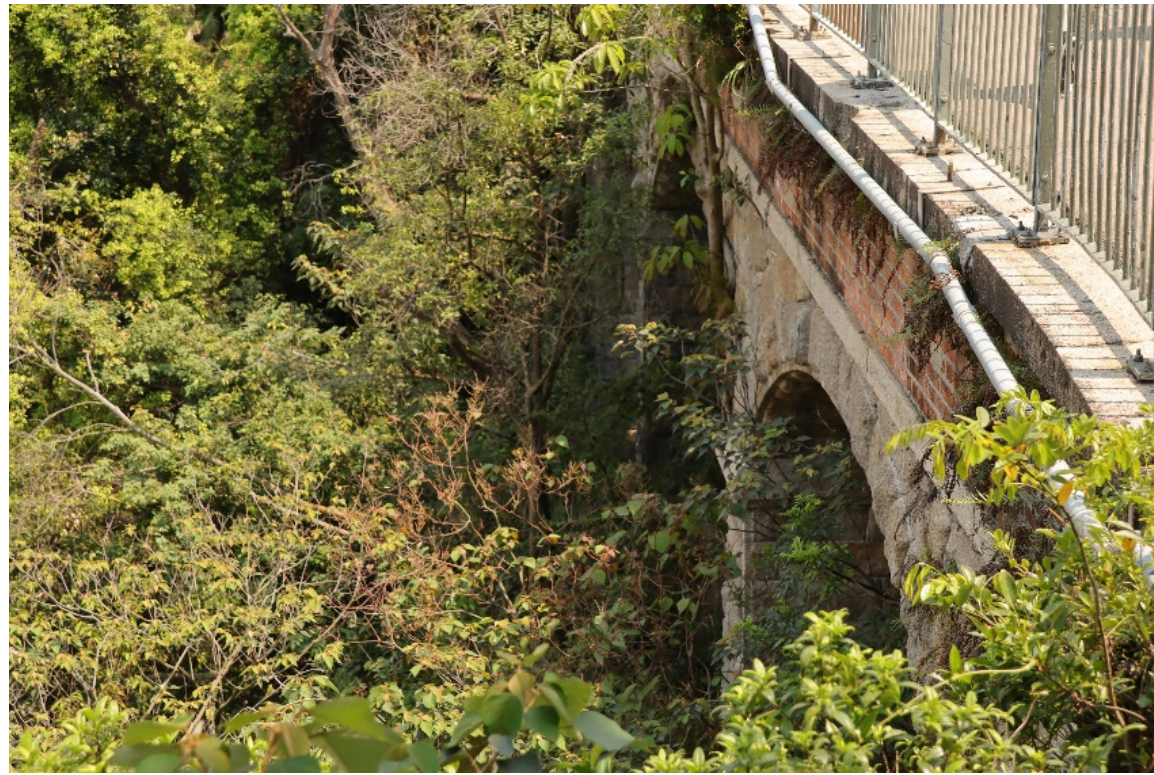
DM-05 - The 21-Arch Section of the Bowen Aqueduct DM-05 - 香港寶雲輸水道的21孔拱券段
