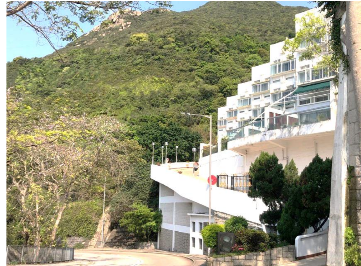
Day 1 after completion 工程完成後第一天
