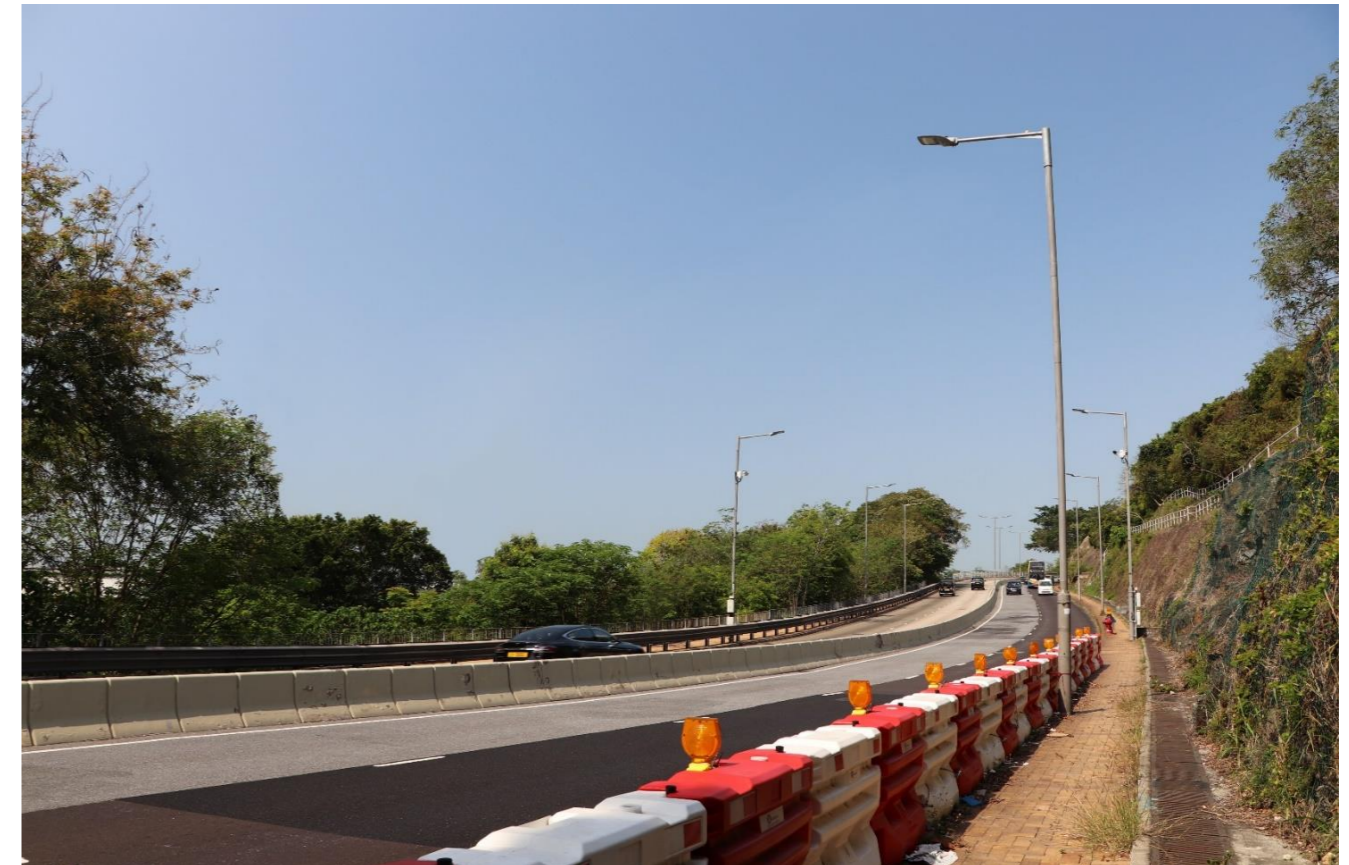
Day 1 after completion 工程完成後第一天
