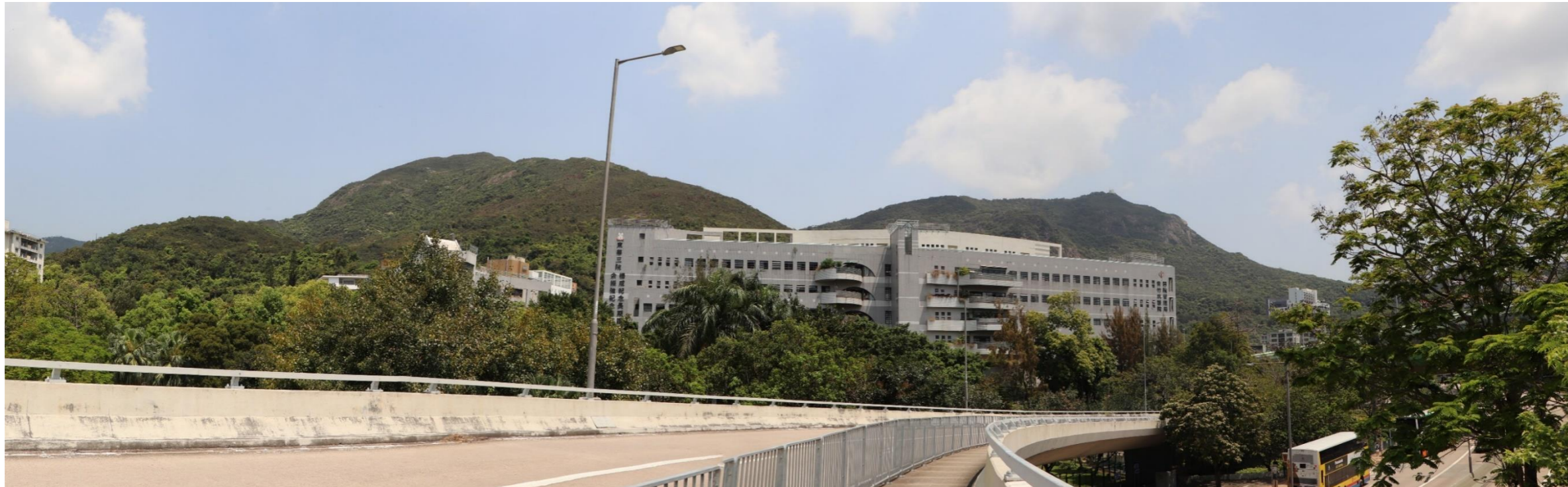
Day 1 after completion 工程完成後第一天
