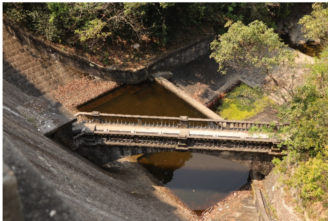
DM-04 - Aberdeen Upper Reservoir, Bridge DM-04 - 香港仔上水塘的橋
