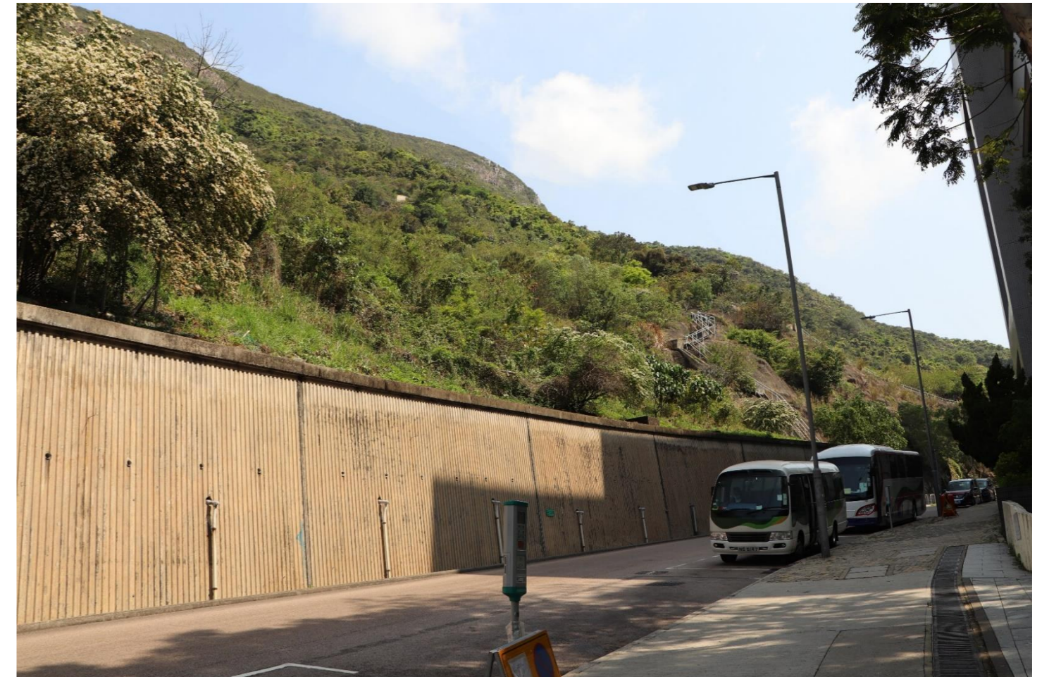
Day 1 after completion 工程完成後第一天
