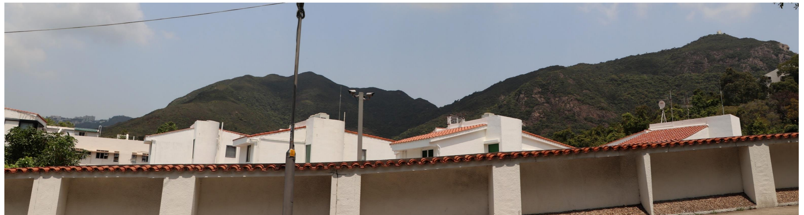
Day 1 after completion 工程完成後第一天
