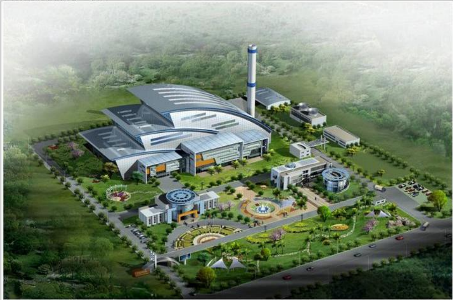
广州市南沙垃圾焚烧发电厂—鸟瞰图
