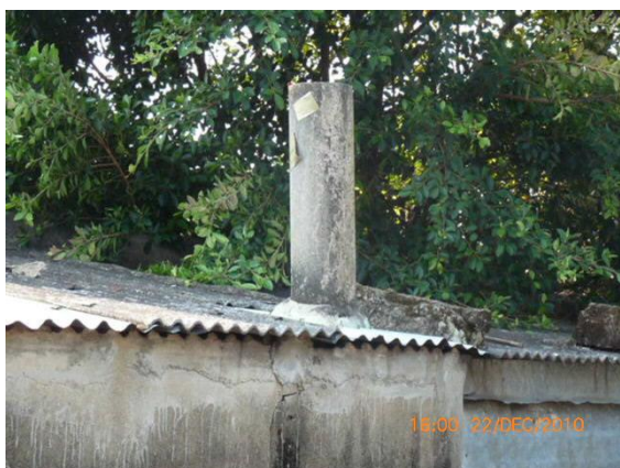
與其他含石棉物料相連的石棉瓦屋頂擋板（上圖例子為石棉水泥煙道）
