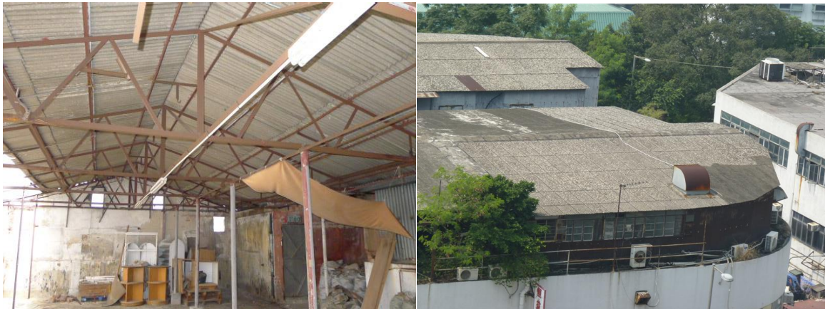
石棉瓦屋頂擋板
