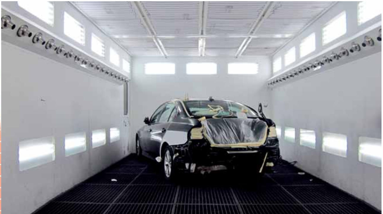
可在噴漆房的牆上頂部安裝吹風嘴系統（一排排的吹風嘴）（建議設置，非必要性），縮短水溶性漆料的乾燥時間
