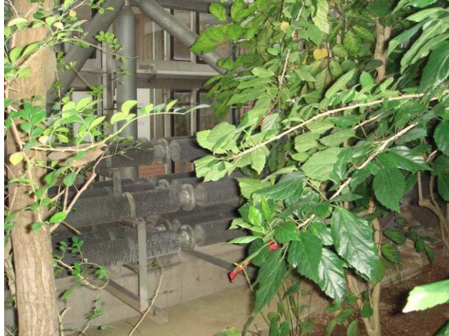
圖十三、 植物館內經過熱能交換器的暖管
