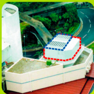
隔音罩 鮮風出入口減聲器
