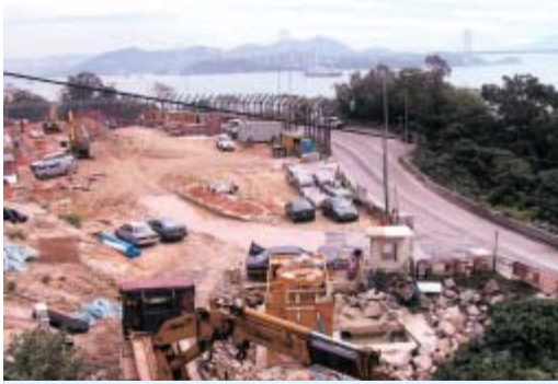
正在進行中的青山公路擴闊工程 Castle Peak Road widening work in progress
