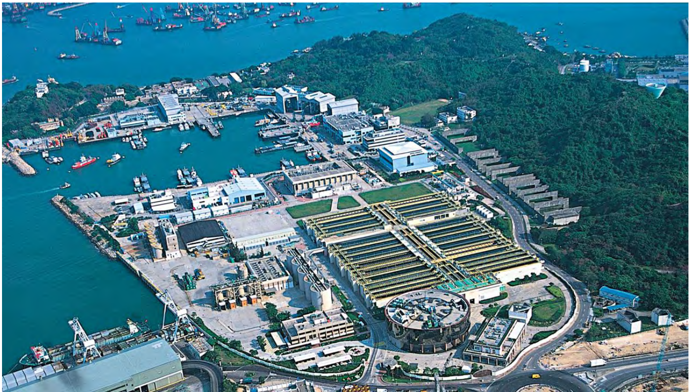
昂船洲污水處理廠是目前全球同類型中最大的污水處理廠
