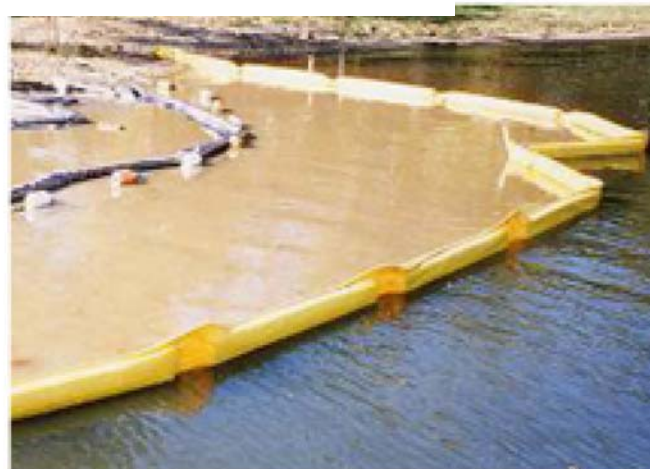
Silt Curtain in Use 使用隔泥幕
