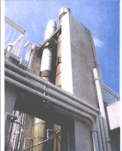
在屋頂上的焚化爐煙囪
