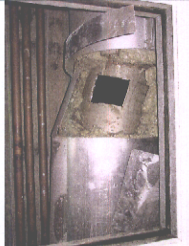
在下層的垂直管道被切開作 視察用途
