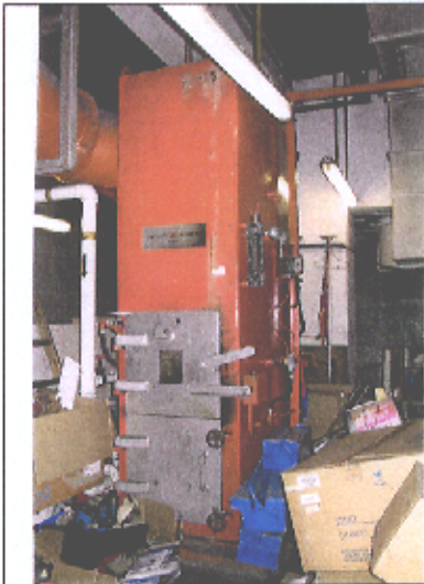
將被拆卸的焚化爐
