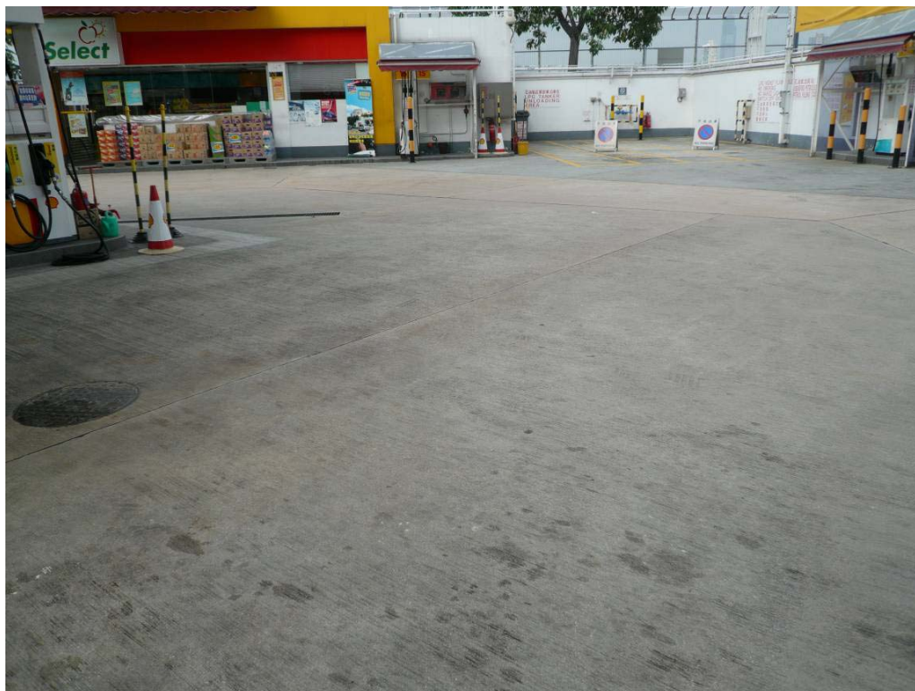
從蜆殼加油站觀察所得，加油站的地面是被混凝土覆蓋，並且沒有任何裂痕和油污。
