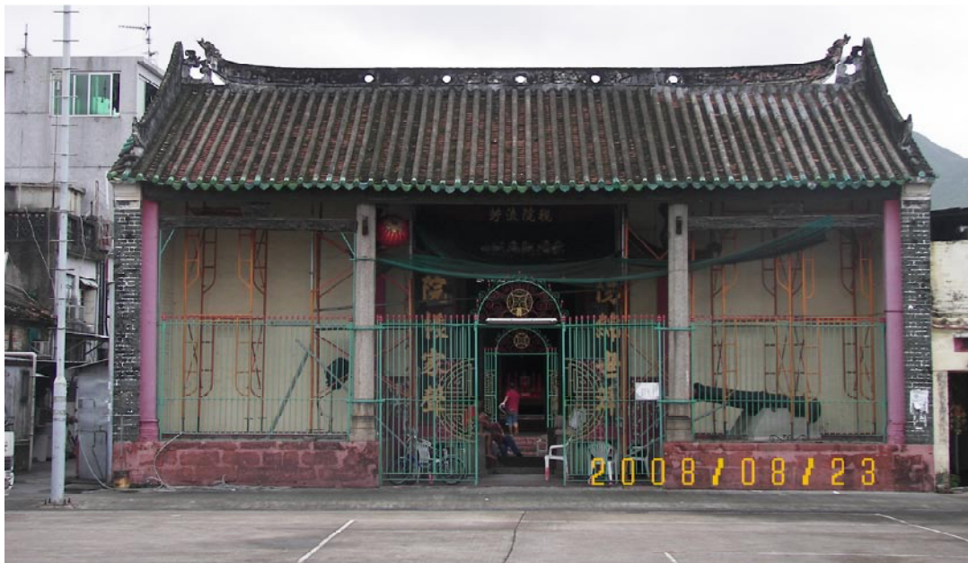
相片一 鄧氏宗祠的正面。古物古蹟辦事處已為該宗祠安裝支撐鐵架，修復工程亦會清除牆壁及石柱上的現代油漆。
