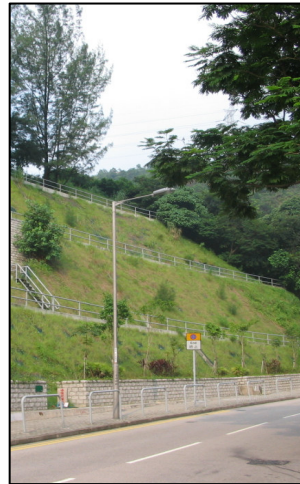
經過安裝泥釘、景觀處理及保留現有樹木後的綠化斜坡的例子
