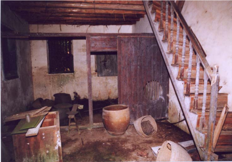
Photo 2 Main Building Ground Floor (Side bay) 相片 2 主樓地下(次間)
