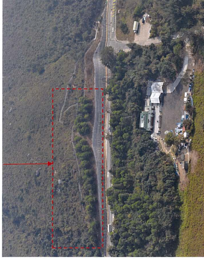
插圖 5a – 鳥瞰圖顯示了在柔性泥石防護屏障前面的泥石穴種植 (地點：東涌道)
