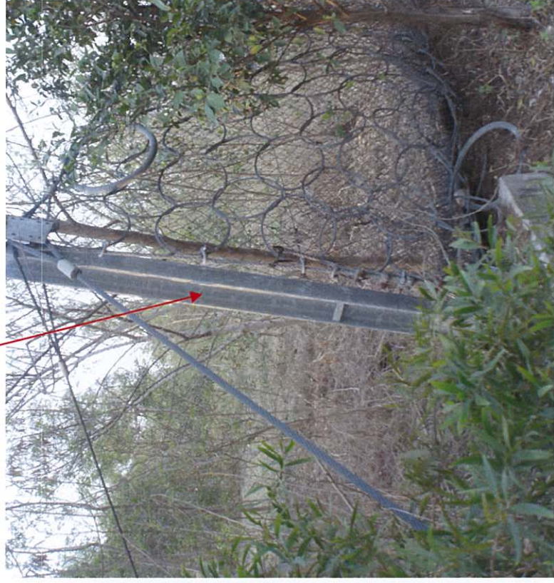
柔性防護網和支柱的特寫圖
