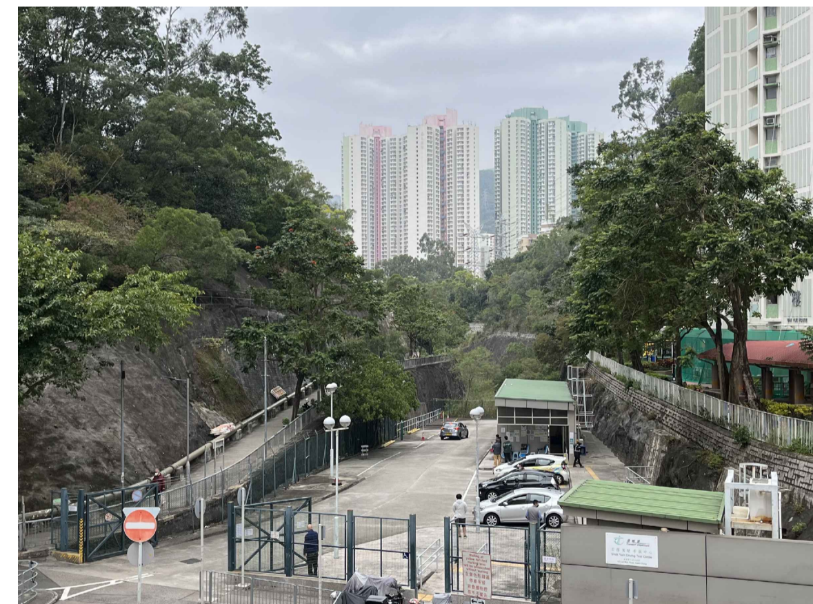
VSR-T5 TRAVELLERS ON SHEK PAI STREET FOOTBRIDGE VSR-T5 石排街行人天橋遊客
