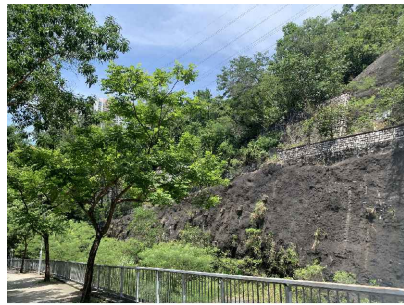
PHOTO 5431 MAN-MADE SLOPE DATE TAKEN: 24/08/2022 人造斜坡 拍攝日期: 2022年8月24日
