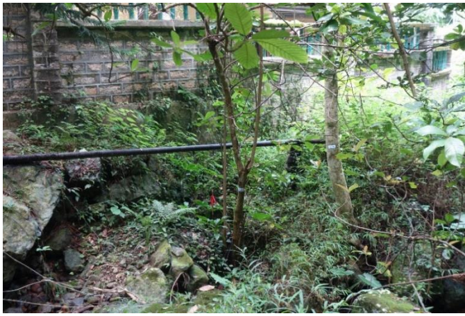
相片 3 導流牆(DW01)的指示性位置
