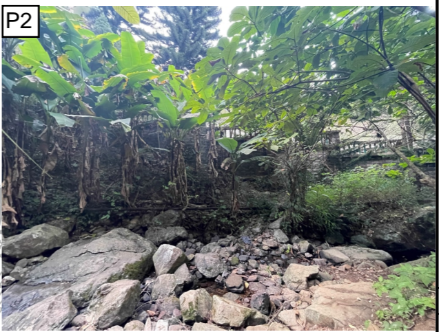
PLATE 2 - INDICATIVE LOCATION OF DEFLECTOR WALL DW01 相片2 - 導流牆DW01的指示性位置
