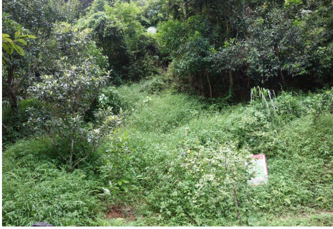
相片 1 泥石流(RB01)的指示性位置
