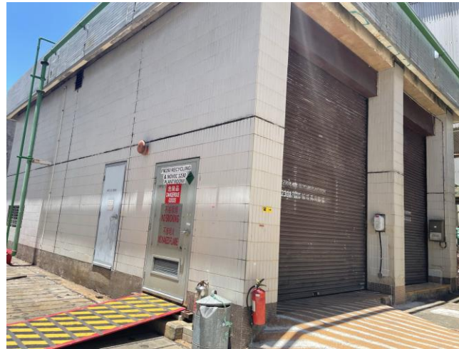
Photo 74: Operation store of FM200 Recycling & NOVEC 1230 plant room 照片 74 : FM200 和NOVEC 1230的營運儲存室和回收機房
