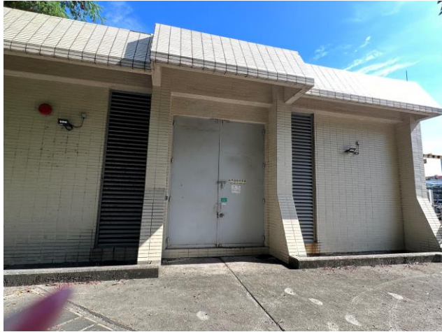
Photo 85: Cooling water system control room 照片 85 : 冷卻水系統控制室
