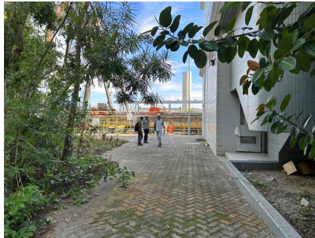
Photo 95: Brick pavers area outside the GT57 & Coal Jetty Electrical Equipment Building 照片 95 : GT57號機組及運煤碼頭電氣設備機樓外以地磚鋪築的地區
