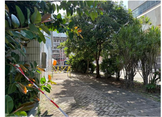
Photo 96: Brick pavers area outside the GT57 & Coal Jetty Electrical Equipment Building 照片 96 : GT57號機組及運煤碼頭電氣設備機樓外以地磚鋪築的地區
