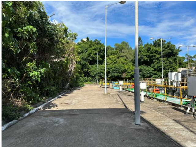
Photo 94: Concrete paving at the southern part of the Project site 照片 94 : 項目位置南部的以混凝土鋪築的地區
