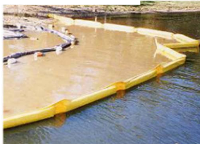
Silt Curtain in Use 使用隔泥幕
