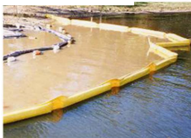
Silt Curtain in Use 使用隔泥幕
