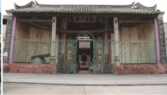
位於鄉村內的歷史建築
