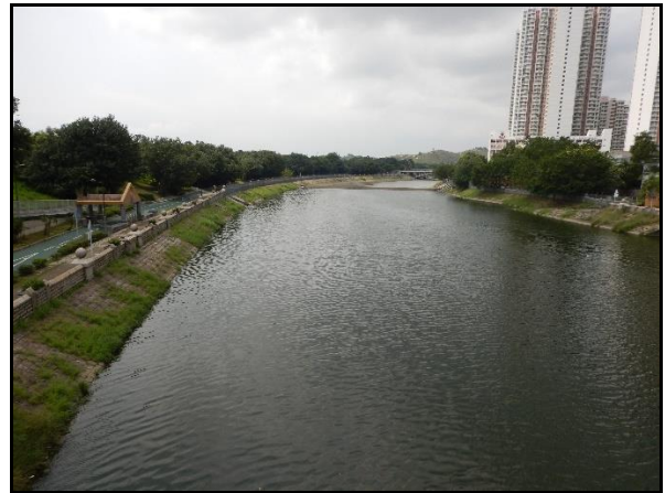
天水圍主河道，河岸以混凝土建成
