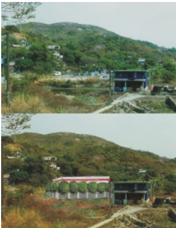
大欖山谷抽水站-完成緩解措施之前(圖上)及之後(圖下)的相片
