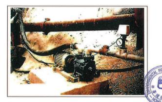
CNP 281 Water pump (electric) 水泵 (電動)
