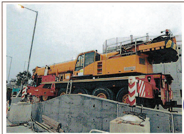
CNP 048 Crane, mobile (diesel) (2) 起重機，流動(油渣)(2)
