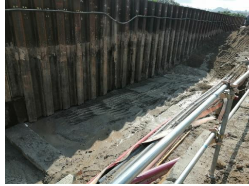
ELS works for Noise Barrier Foundation
