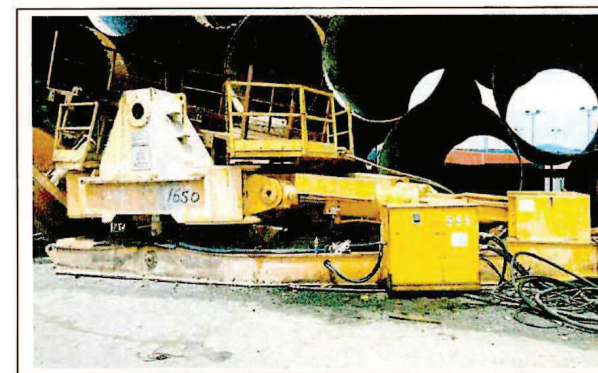
CNP 165 Piling, large diameter bored, oscillator 大直徑鑽孔樁，擺動機
