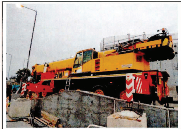
CNP 048 Crane, mobile (diesel) (2) 起重機，流動(油渣)(2)
