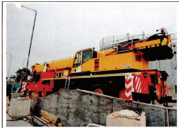
CNP 048 Crane, mobile (diesel) (2) 起重機，流動(油渣)(2)
