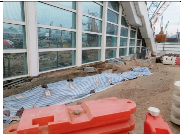
ELS works for Noise Barrier Foundation
