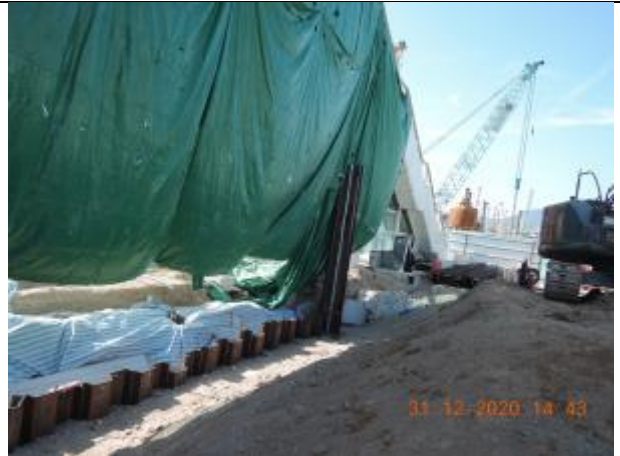
ELS works for Noise Barrier Foundation
