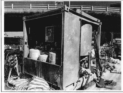
Wastewater treatment plant 污水處理器
