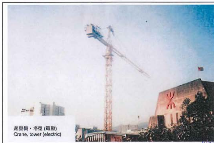
CNP 049 Crane, tower (electric) 起重機，塔型(電動)
