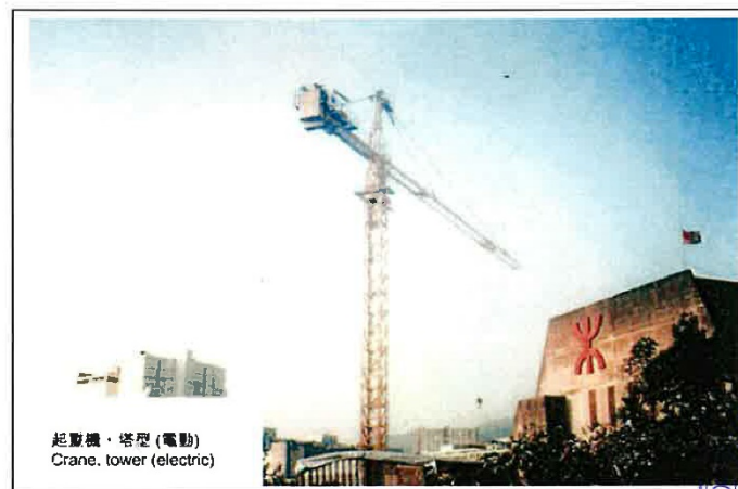
CNP 049 Crane, tower (electric) 起重機，塔型(電動)
