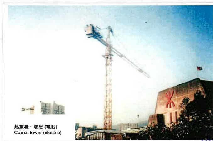
CNP 049 Crane, tower (electric) 起重機，塔型 (電動)
