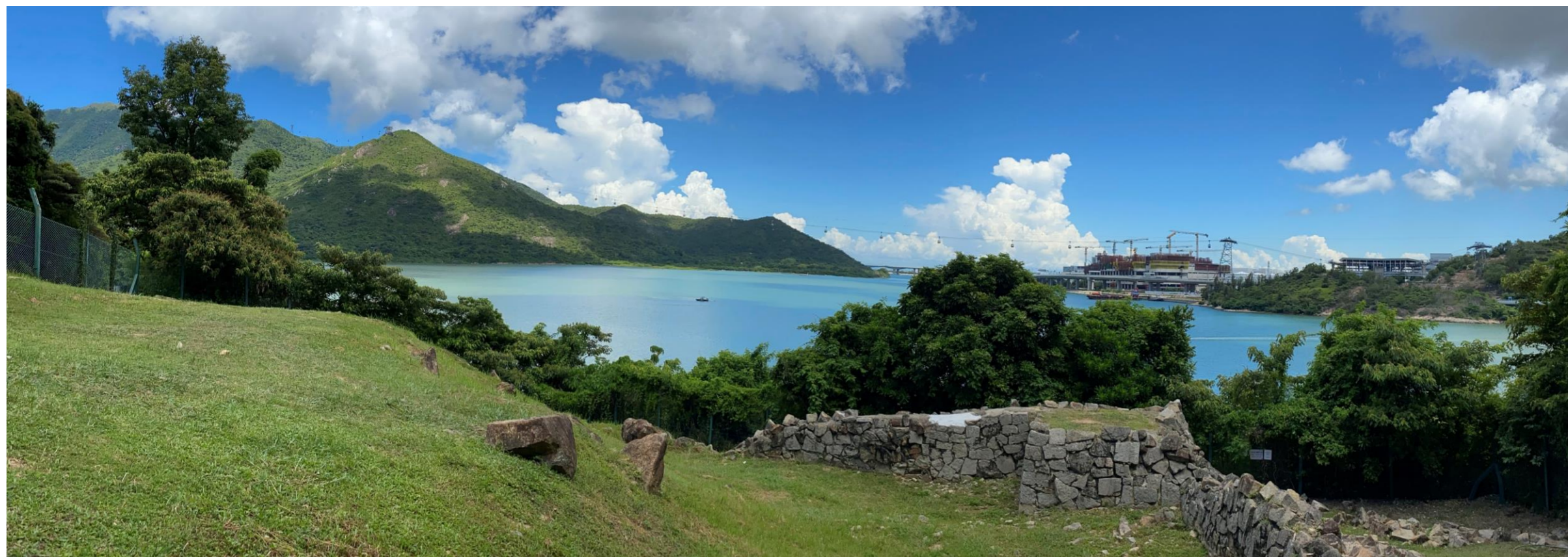
VSR 9 Tung Chung Battery
