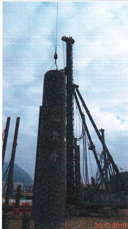
Noise Barrier: NB11 Hammer: HH-1+
