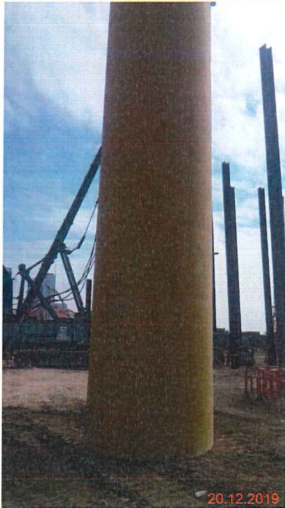
Noise Barrier: NB04 Hammer: HH-01
