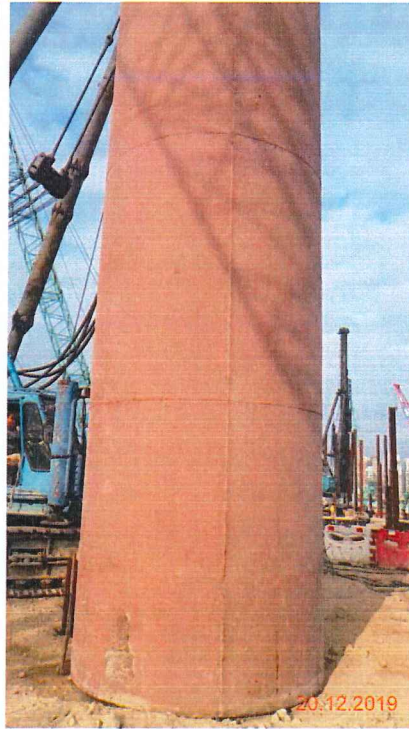
Noise Barrier: NB02 Hammer: HH-04
