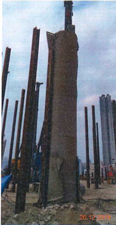
Noise Barrier: NB01 Hammer: HH-05
