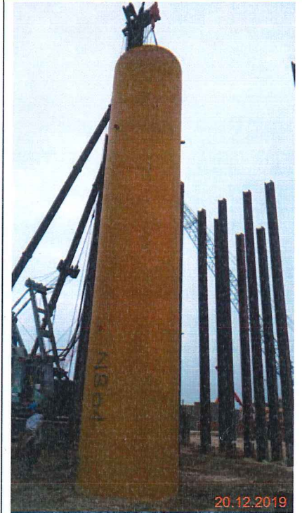
Noise Barrier: NB04 Hammer: HH-02
