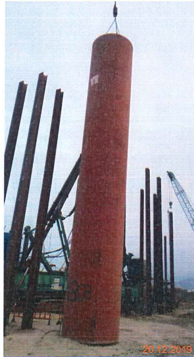
Noise Barrier: NB03 Hammer: HH-01
