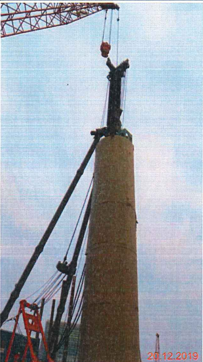
Noise Barrier: NB07 Hammer: HH-10
