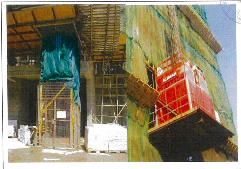
CNP 122 Hoist, passenger/material (electric) 吊機，乘客/物料 (電動)
