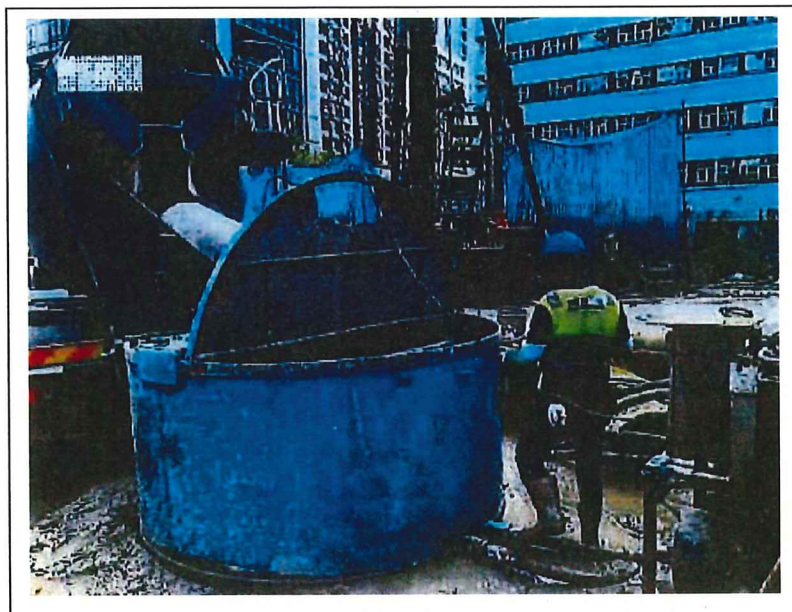
Grout mixer 灌漿攪拌機
