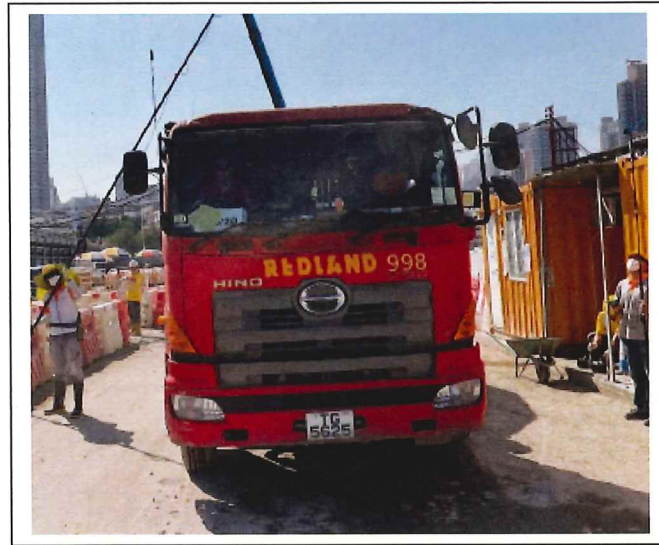
Concrete lorry mixer (Vehicle No. TG5625) 混凝土攪拌車 (車牌號碼 TG5625)
