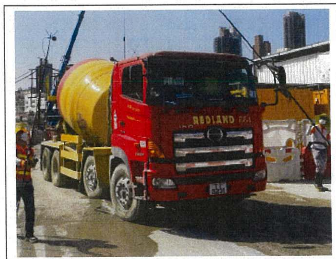
Concrete lorry mixer (Vehicle No. TT3231) 混凝土攪拌車 (車牌號碼 TT3231)
