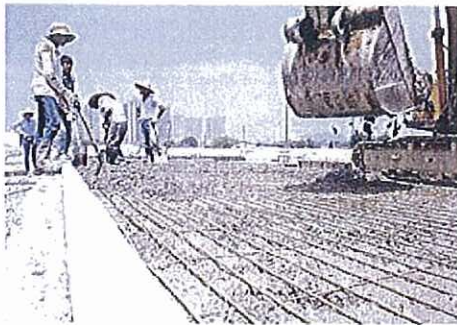
Paving of Motor way 鋪設行車公路
