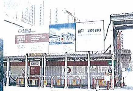
MTR Tseung Kwan O Station 地鐵將軍澳站
