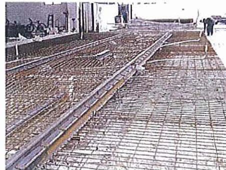
Concrete Pavement 混凝土地台
