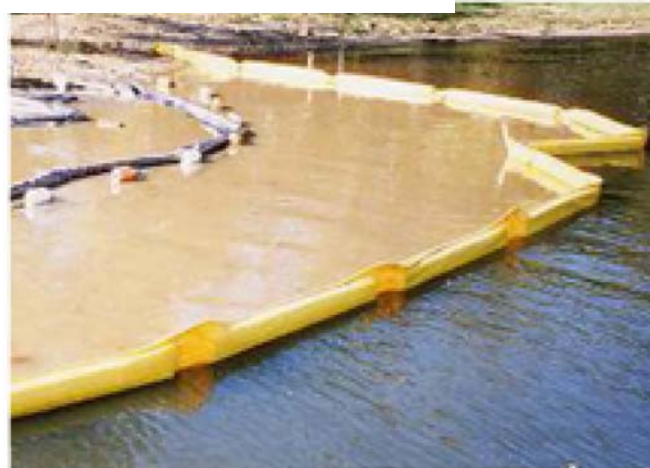
Silt Curtain in Use 使用隔泥幕
