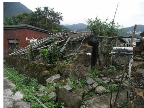
TP04 - Ruin in Tai Po Kau Lo Wai 大埔滘老圍廢屋
