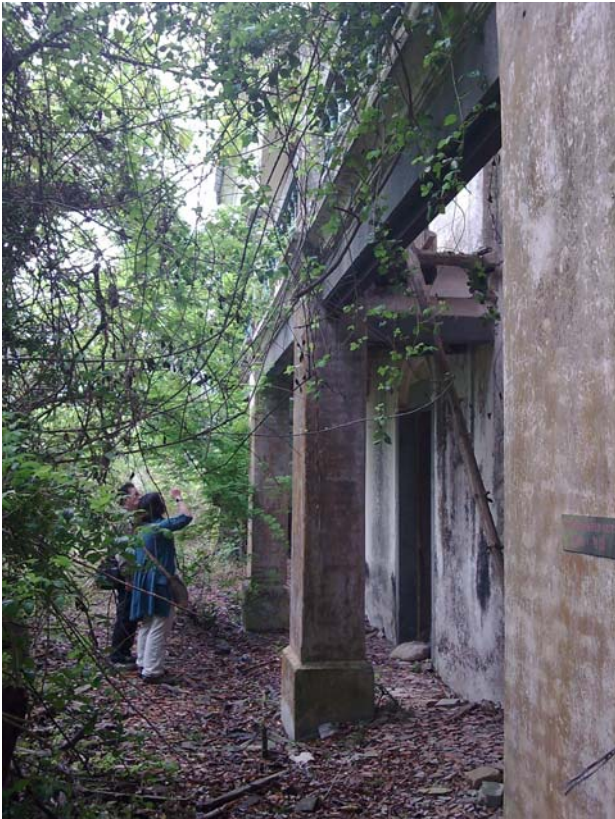
Photo 1 Front Elevation of the Main Building 相片 1 主樓正面
