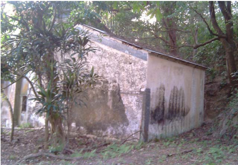
Photo 4 Annex Block (Kitchen Annex) 相片 4 附建物 (附建廚房)
