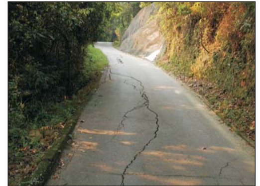
Existing Sha Lo Tung Road
