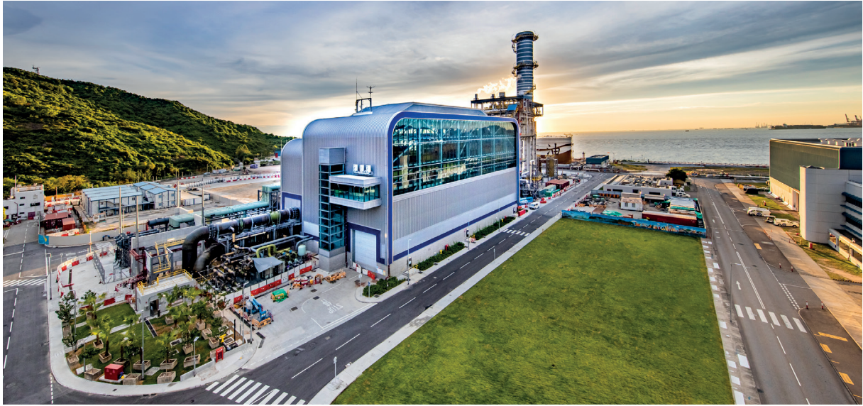
位於龍鼓灘發電廠新增的燃氣發電機組
