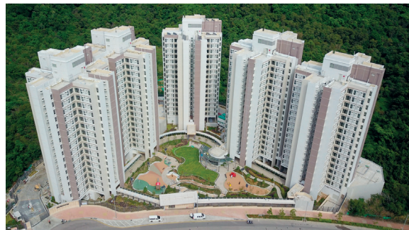
位於將軍澳的消防處百勝角已婚人員宿舍是香港首批採用混凝土「組裝合成」(MiC) 興建的多層建築項目
