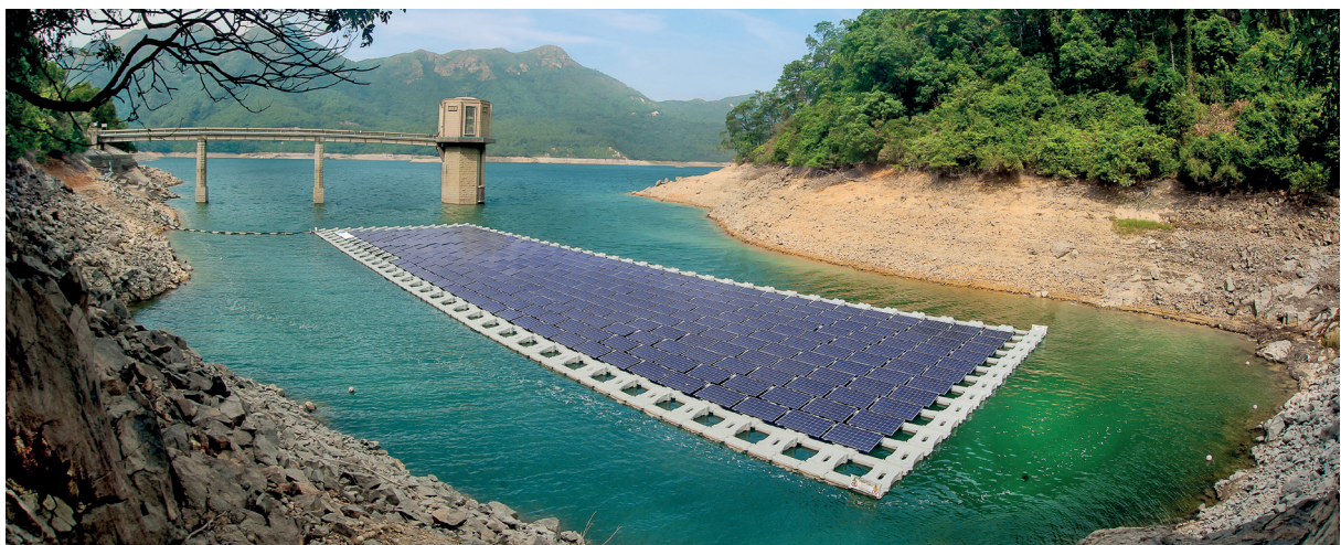
位於石壁水塘的浮動太陽能發電系統
