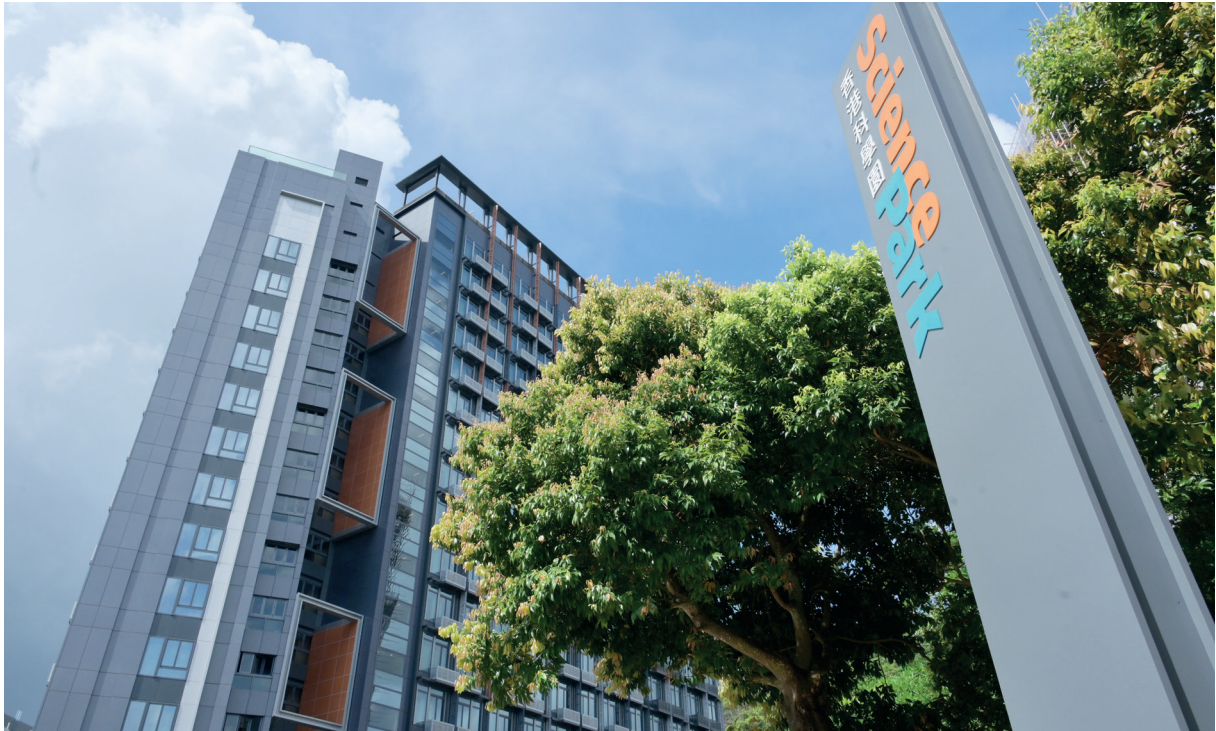
位於科學園的創新斗室是香港首批「組裝合成」(MiC) 高樓層建築項目
