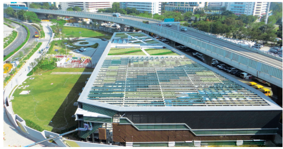
啟德發展區區域供冷系統
